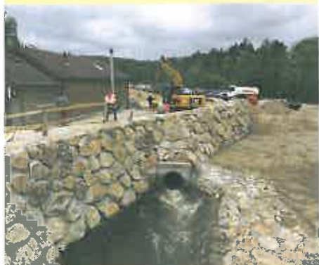
Hochwasserschutz im Bereich des Mühlbachstübers
