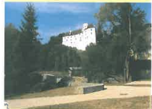
Hochwasserschutz im Bereich Kreuzung Sieghartser Straße
