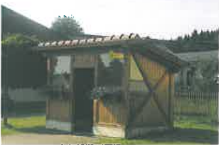
♣ Im Jahre 2002 wurde ein Wartehäuschen für die Bus-Kinder gebaut.
