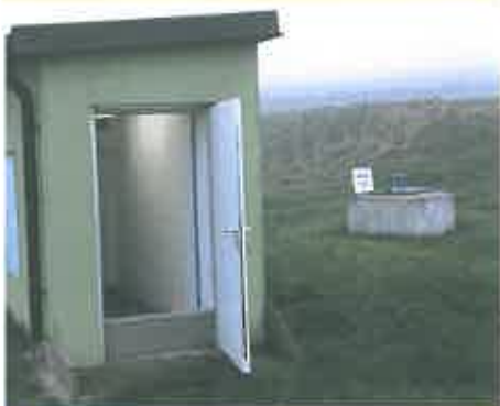
Die Pumpstation Griesbach wurde kurzzeitig überschwemmt!
